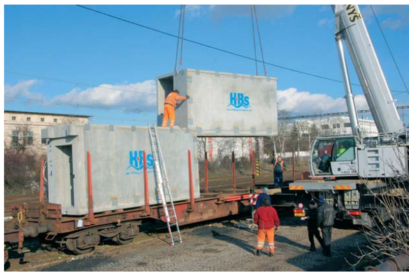
Nakládka prefabrikovaných věžeňských cel v Praze-Hostivaři Foto: Archiv ČD Cargo
