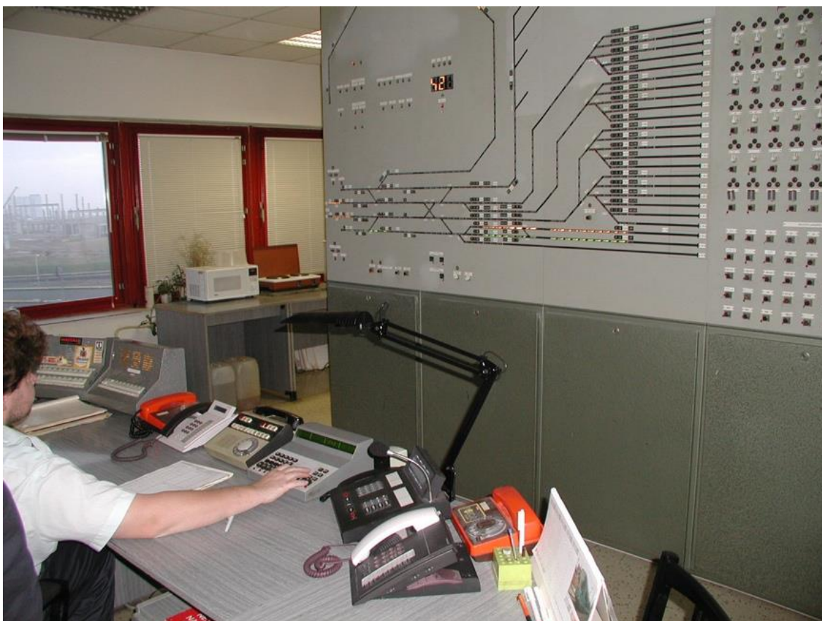
Obrázek 8: Reléové zařízení „číslicovka“ na depu Zličín 8
