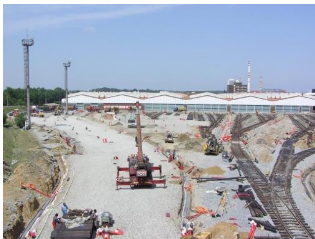
Obrázek 3: Rekonstrukce zhlaví depa Hostivař 3
