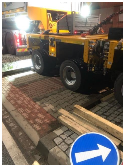
Fotografie 4: Přejezd dopravního ostrůvku za pomoci výdřev 8
