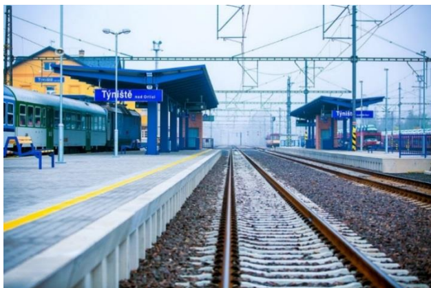
Obr. č. 5 celkový pohled na ŽST Týniště nad Orlicí
