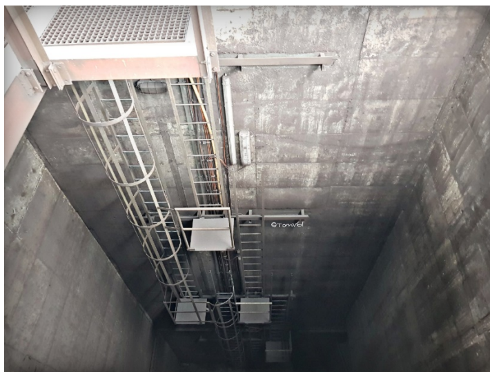
Foto 23 - Sestup do přivaděče
