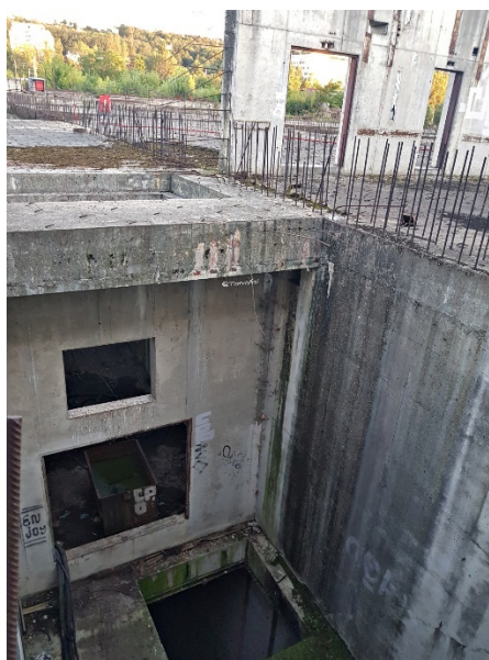
Foto 27 - Betonové základy a kus podzemní sekce
