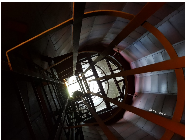
Foto 1 - Větrací šachta DSM
