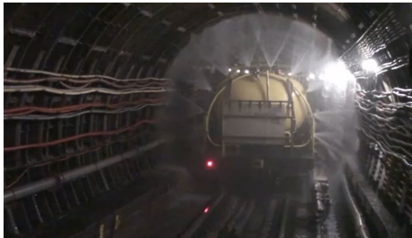
Obrázek 10 - Oplachování tunelu unikátním strojem
