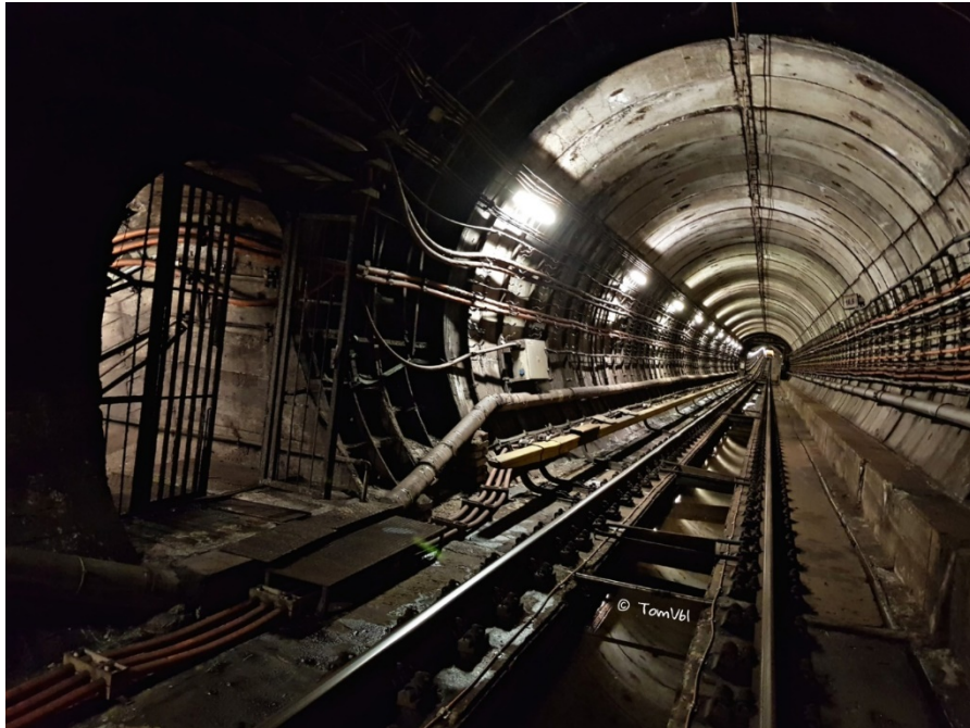
Příloha 9 - vstup do hygibuňky z tunelu
