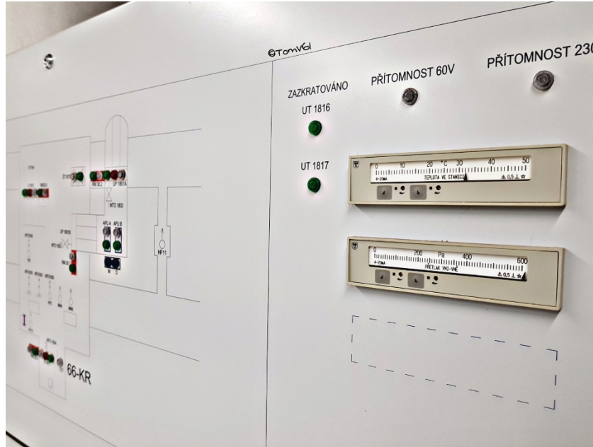
Příloha 11 - SŘP: ukazatele teploty a tlaku vzduchu v ochranném úseku
