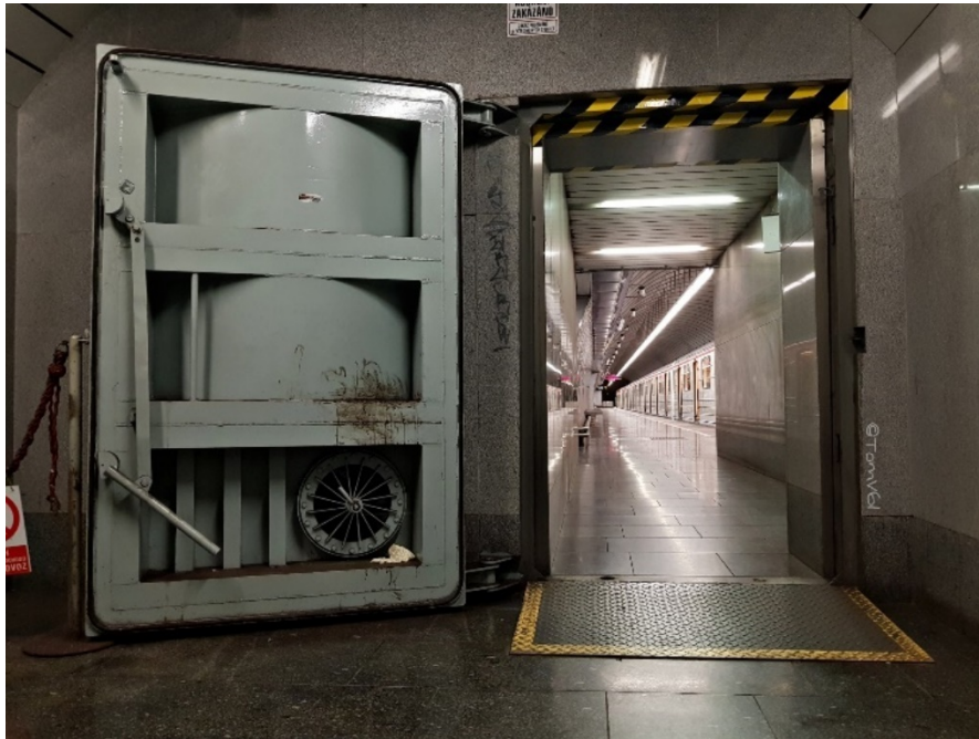
Příloha 1 - přístup k výtahu st. Kolbenova
