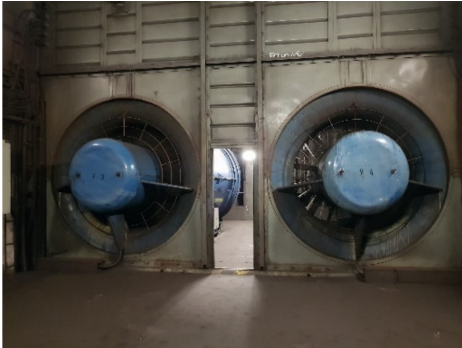
Příloha 3 - vlevo uzavřený, vpravo otevřený mžikový uzávěr ventilátoru
