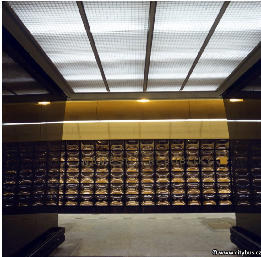
Příloha 13 - původní architektonický ráz stanice Náměstí Republiky
