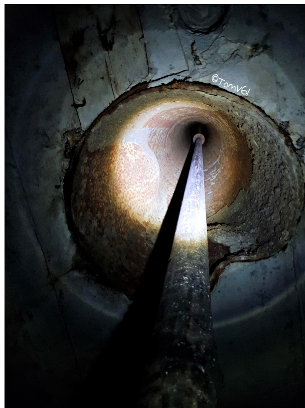
Příloha 8 - pohled vzhůru do hlubinného vrtu na povrch
