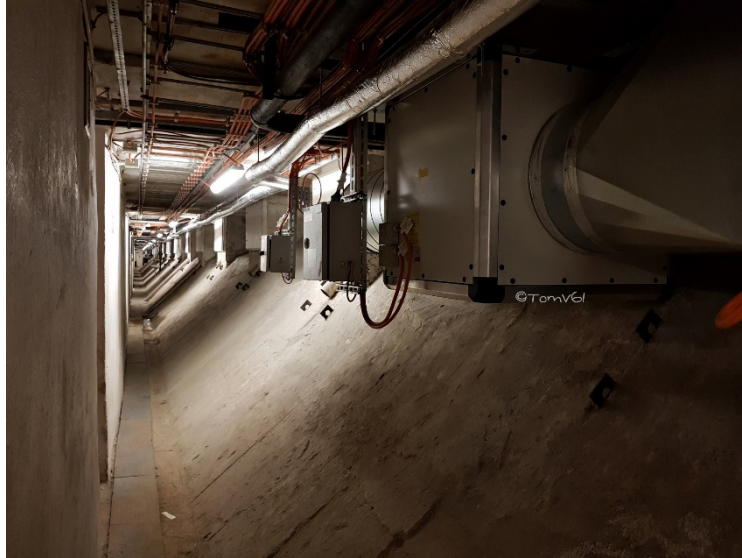
Foto 18 - Prostory pod nástupištěm trojlodní stanice
