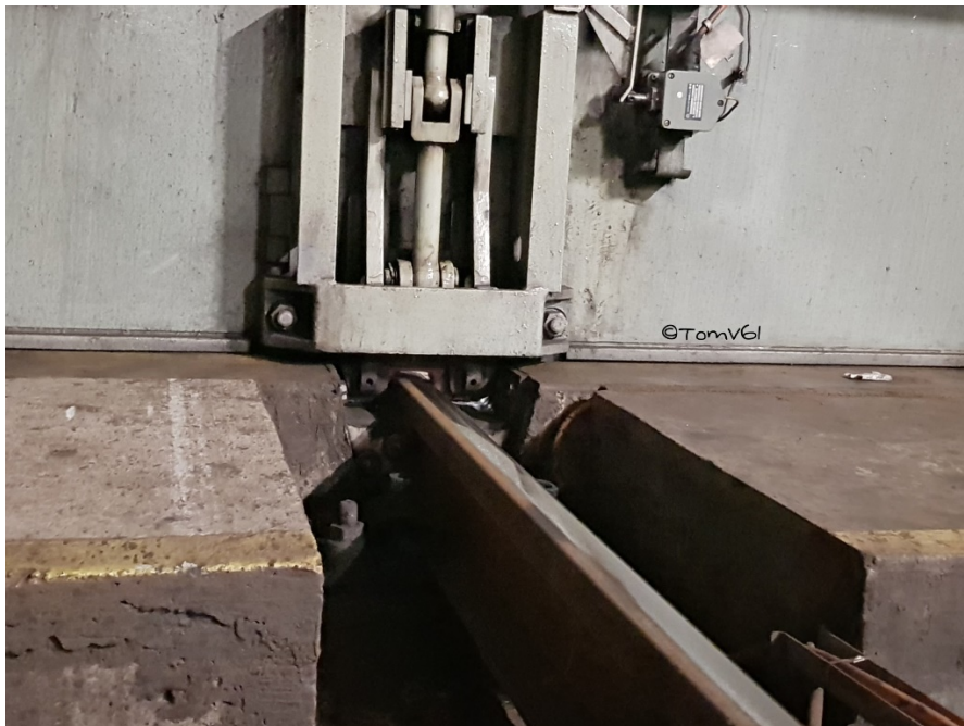
Příloha 4 - utěšňovač kolejnice při dovírání
